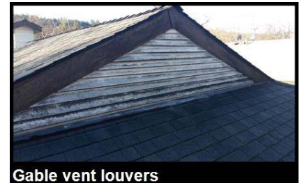
Gable vent louvers
